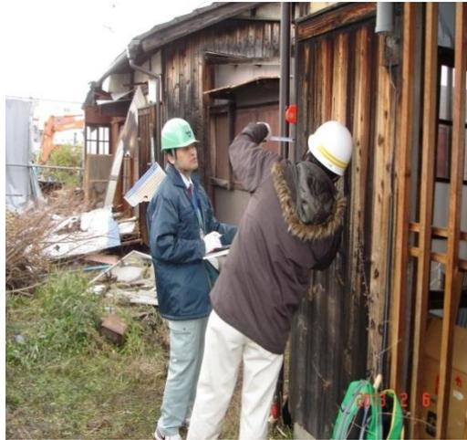
Bランク 柱の傾斜が著しく、数本に腐朽又は破損が生じており、梁が腐朽、破損し、大修理を要すもの(50点)
