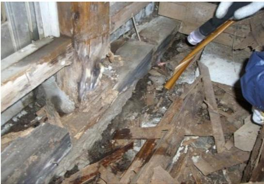
Cランク 柱の腐朽、破損又は変形が著しく、崩壊の危険があり、建築物の除却が必要なもの(100点)
