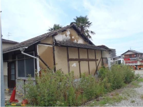
B ランク 外壁面に著しい剥落、ずれ、破損が生じており、大修理を要すもの (25 点)
