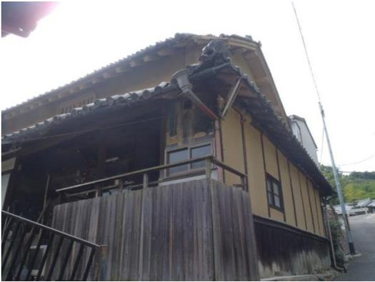
B ランク 屋根ぶき材料に、著しい剥落、ずれ、破損等が生じており、
