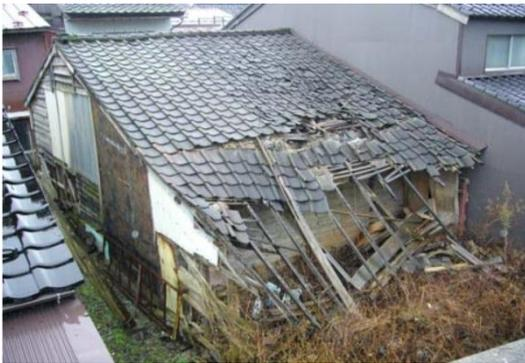
C ランク 屋根が著しく変形、若しくは屋根ぶき材料に、全面的に剥落、ずれ、破損等が
