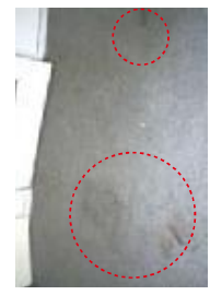
飲み物等をこぼしたことによるカーペットのシミ 手入れ不足等で生じたもの⇒ 借主負担
