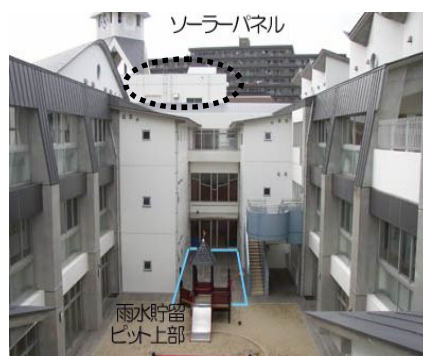
中庭部分(雨水貯留ピット・ソーラーパネル)
