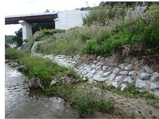
緩傾斜護岸の全景
