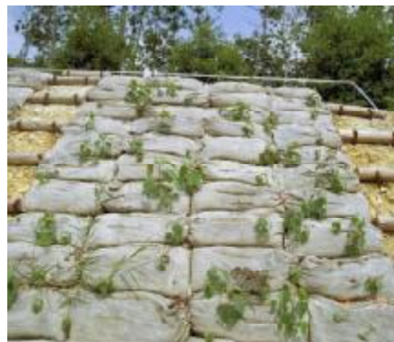
写真 3.2.2 法面への設置イメージ 平成 9 年 9 月満濃町 法面の土のうから発芽したアカメガシワなど
