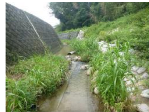
平成26年ごろ 施工
