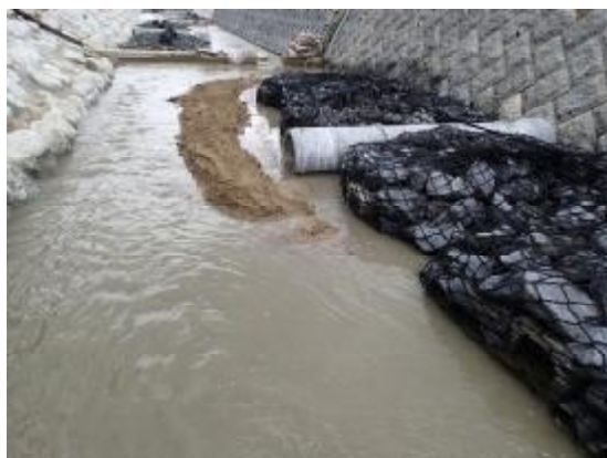
写真 3.2.4 ヒューム管等の設置
