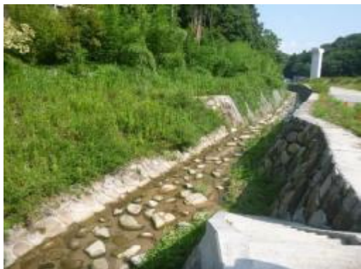
平成24年ごろ 施工
