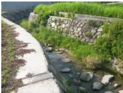
平成24年ごろ 施工
