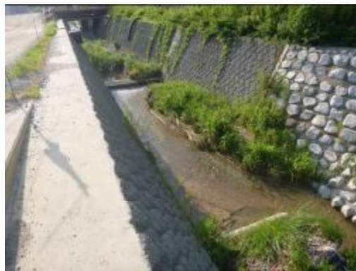
平成25年ごろ 施工
