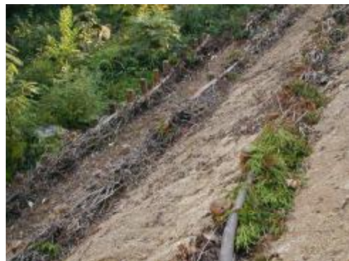
写真 3.2.1 木杭、丸太などによる法面保護
