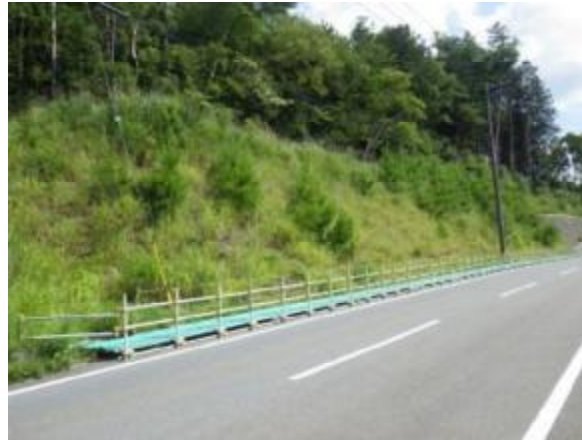
マザーソイル工法 平成23年～平成24年 施工
