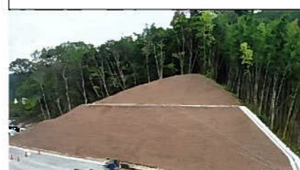
現地森林表土を使用した植生基材吹付
