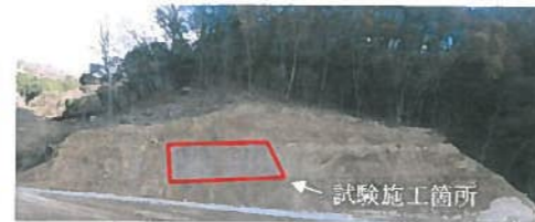
写真 2-1 試験施工箇所全景
