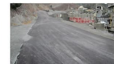
粉塵低減率の高いアスファルト舗装
