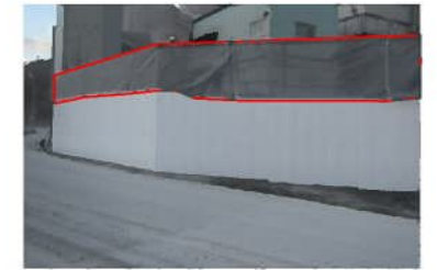
防塵ネット (赤枠部)
