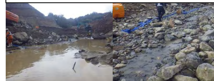
河川切替後の状況
