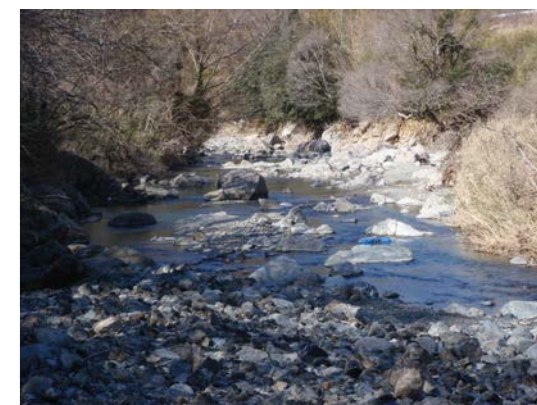
仮々締切設置周辺写真
