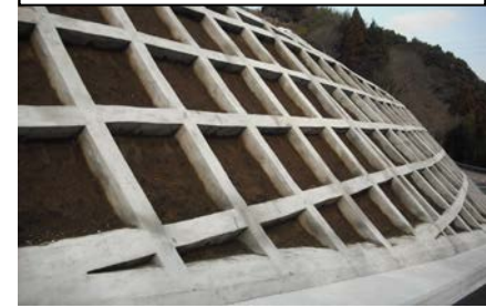
現地森林表土を使用した植生基材吹付工
