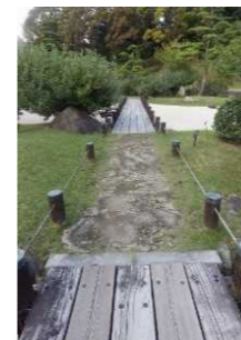
c 木橋・土舗装部
