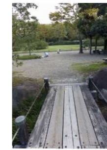
c 砂利舗装部
