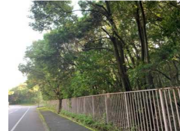
【第2工区 緩衝林外周】
