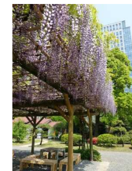
イメージ（柱・梁は丸太材、垂木は竹材）
