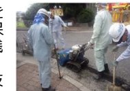
日常維持管理(段差補修)
