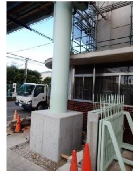
建屋耐震補強③
