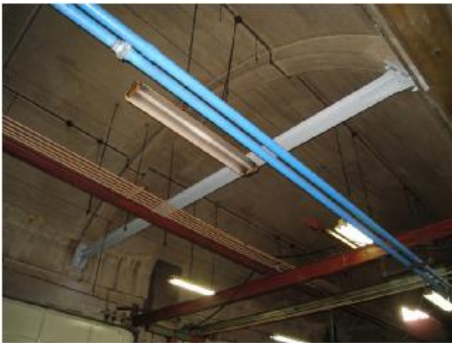
建屋耐震補強④
