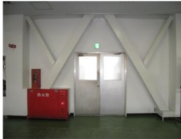
建屋耐震補強②
