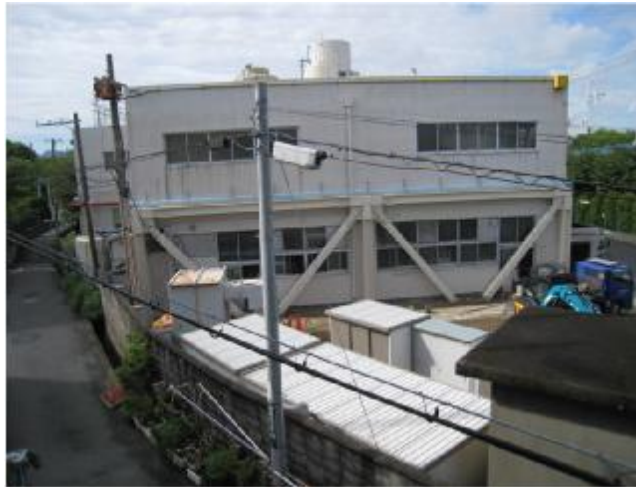
建屋耐震補強①
