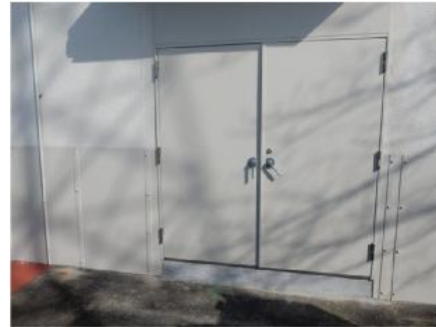
電気設備への浸水対策
