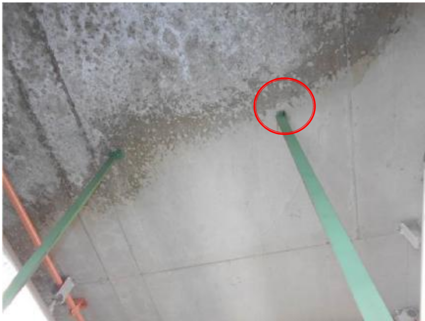
塗料等の保管棚を天井とアンカーで固定
