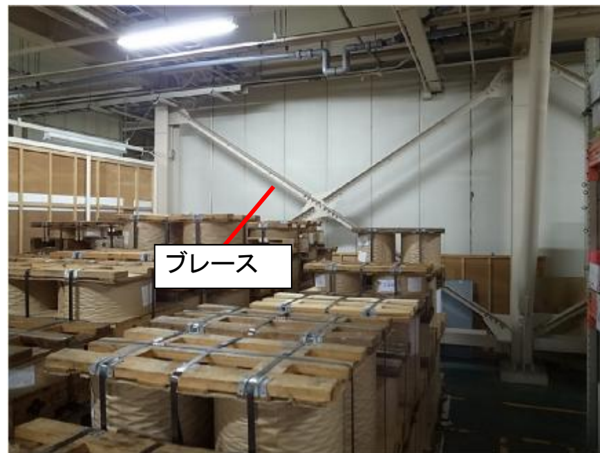
建物のブレースによる補強
