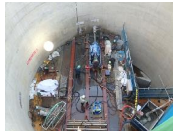
接続管 施工状況
