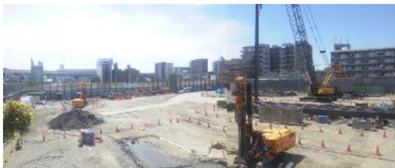
布施公園調節池 現場作業状況
