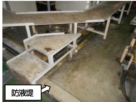
防液堤内部の床をコーティング
