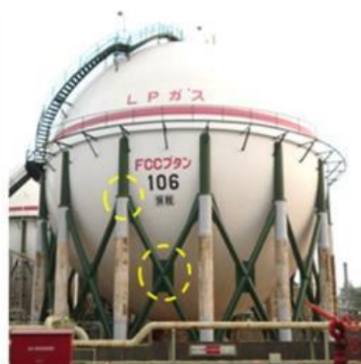
補強工事実施後
