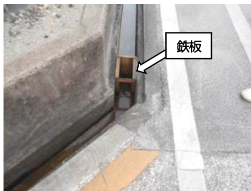
鉄板による排水溝の閉止
