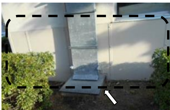
鉄板による補強
