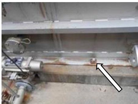
基礎との固定
