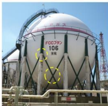
補強工事実施前
