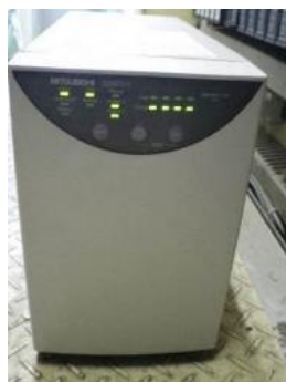
無停電電源装置（UPS）
