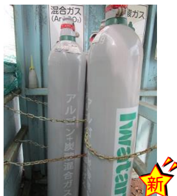
ボンベ等を架台に固定
