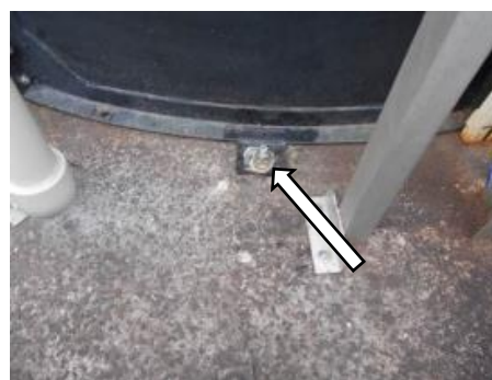
ケミカルアンカー
