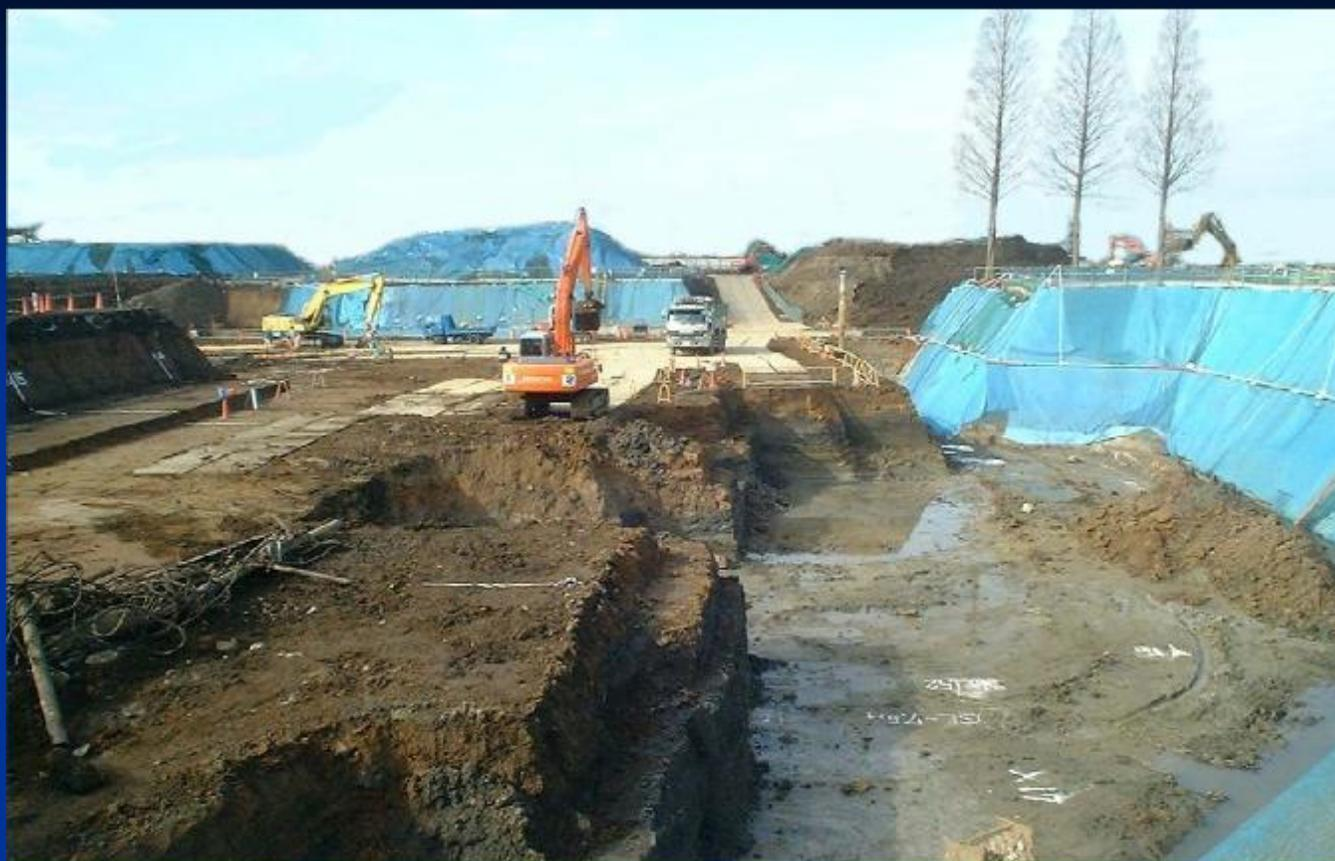
重金属汚染土壌の掘削除去現場. 10m四方の
