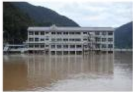
H26. 8 避難所2階の浸水(徳島県)
