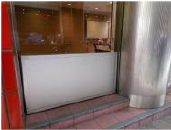
止水板の設置事例
