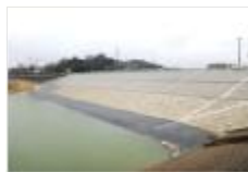
老朽ため池の改修
