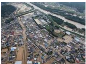
【平成26年度】8月15からの大雨 京都府福知山市の浸水状況
