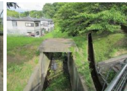
余水吐下流水路
