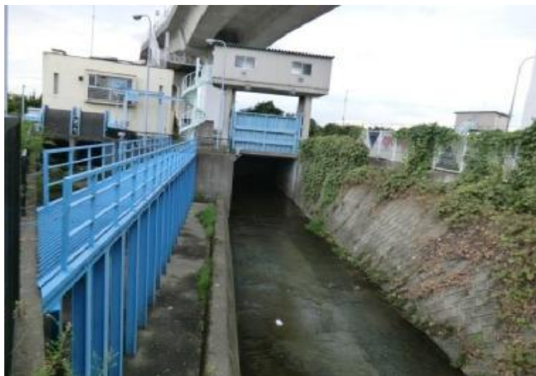
神田川排水機場
