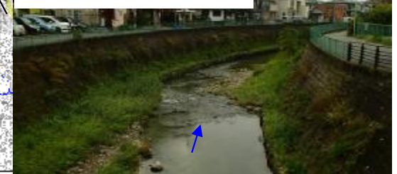
千里川 千里川橋下流部
