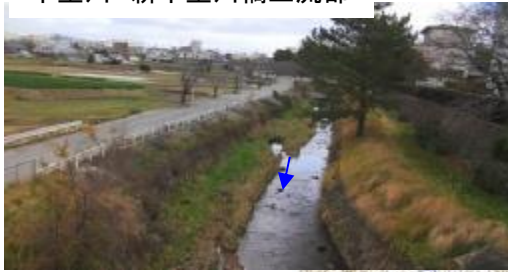
千里川 新千里川橋上流部
