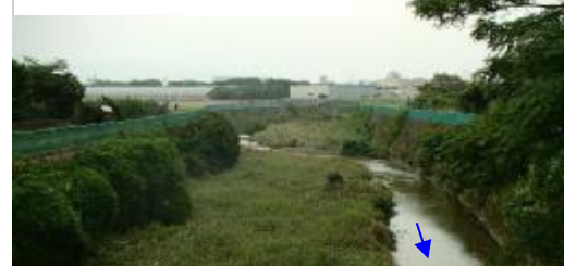
千里川 原田橋上流部
