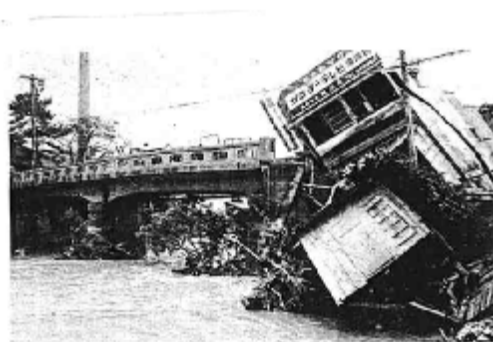
箕面川 桜ヶ丘付近 （昭和42年7月）
