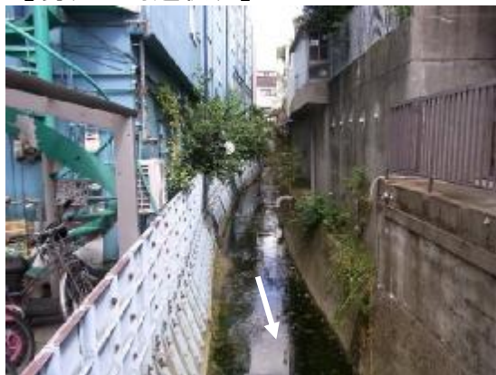
【現況の河道状況】
