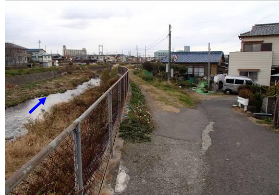
佐野川の下流区間の状況 (築堤区間: 佐野川橋下流)
