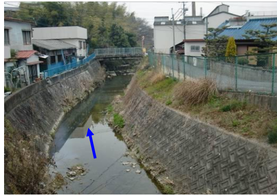
雨山川の上流区間の状況 （無名橋上流付近）
