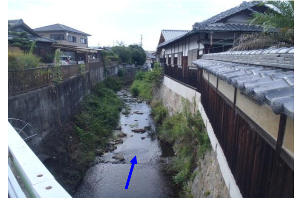
住吉川の上流区間の状況 （紺屋上橋下流付近）
