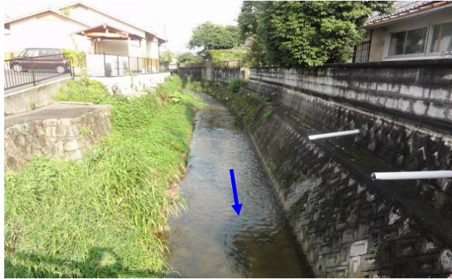
住吉川の上流区間の状況 （万福橋上流付近）
