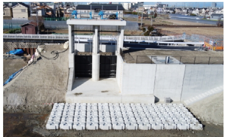
② 排水門完成状況(令和3年1月19日時点)
