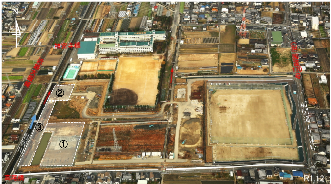
恩智川（法善寺）多目的遊水地 全景写真（令和元年12月）
