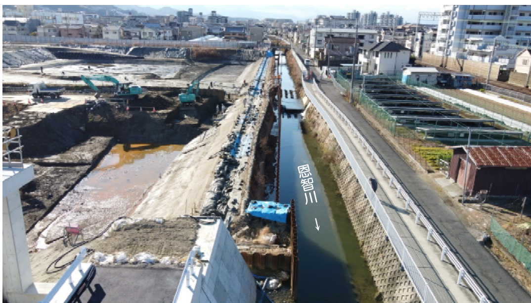
③ 越流堤（※）掘削状況（令和3年1月19日時点）
