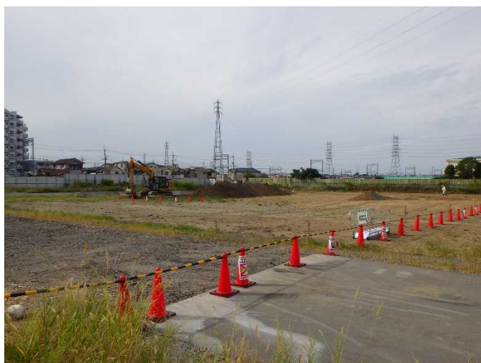
①-1 文化財掘削状況(令和元年10月1日時点)
