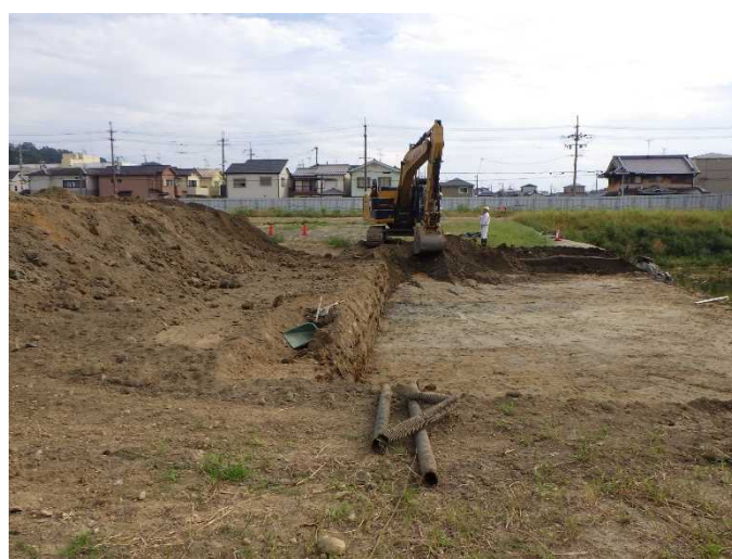
①-2 文化財掘削状況(令和元年10月1日時点)
