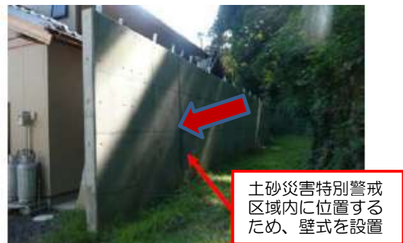
写真 2-4 住宅補強事例
