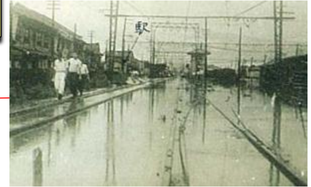
南海泉大津駅構内（泉大津市）
