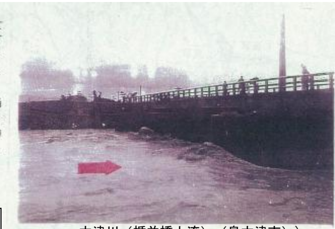
大津川（楯並橋上流）（泉大津市）
