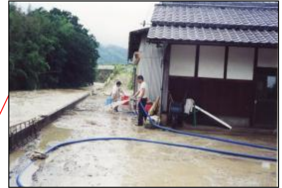
槇尾川神田橋上流（和泉市下宮町）
