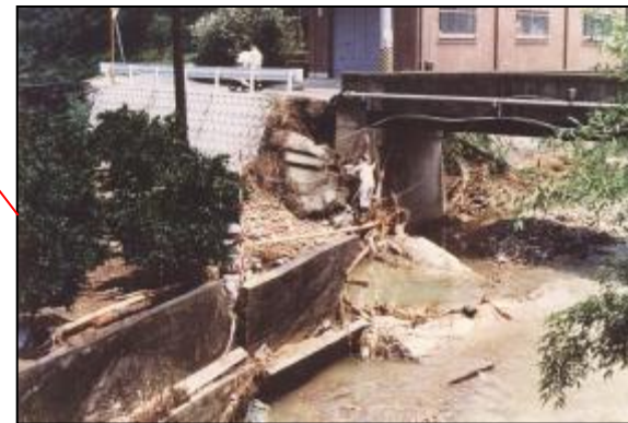
槇尾川地藏橋下流 (和泉市坪井町)
