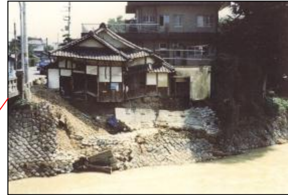
槇尾川川中橋下流 (和泉市三林町)
