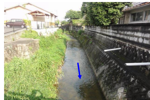
住吉川の上流区間の状況 （万福橋上流付近）
