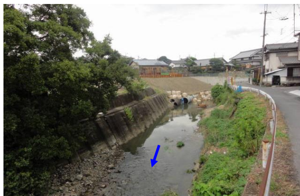
佐野川の上流区間の状況 （国道26号付近）
