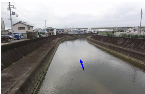
佐野川の下流区間の状況 （昭平橋付近）
