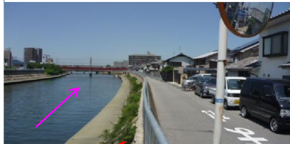
高潮堤防が整備され堤防際に民家がせまる
