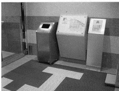
・点字等による案内板 図面は、暗眼者にも使えるように、彩色され、墨字の表記もされている。風除室内に設置され、視覚障害者誘導用ブロックにより誘導している
