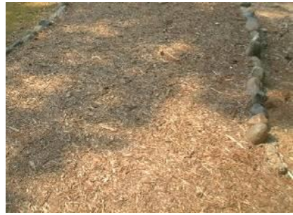
剪定枝や間伐材の粉砕チップを敷き 詰めた園路舗装
