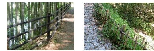
園内にある転落防止柵
