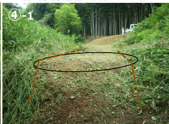
→ チップperを運搬できるように、④-1の部分は斜度が緩くなるように削る
