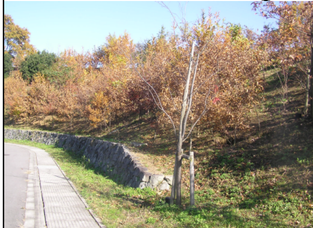
石積と苗木植栽による修景
