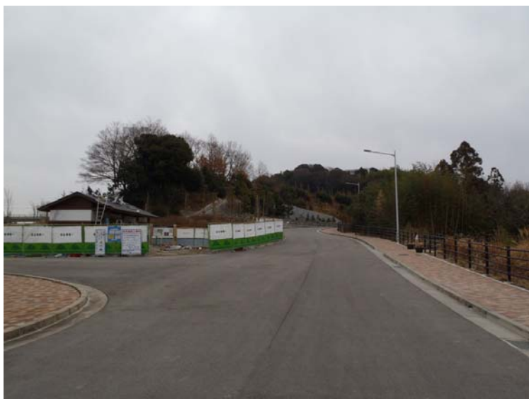
全景（中央口正面より）
