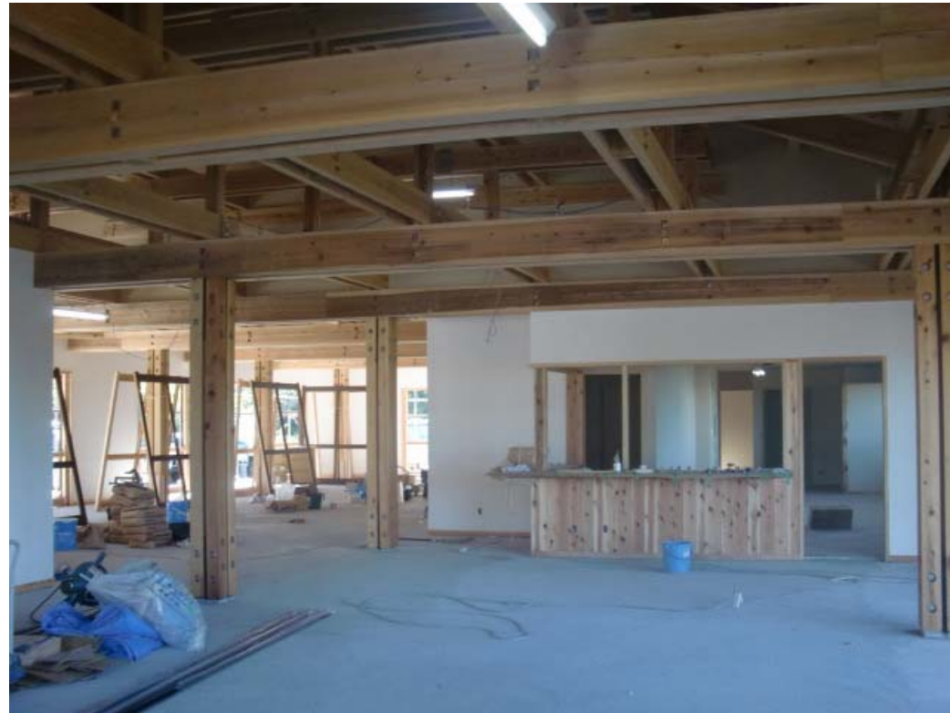
入口よりビジターホールを望む
