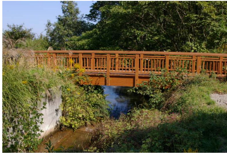
(谷口池西側の既設人道橋)
