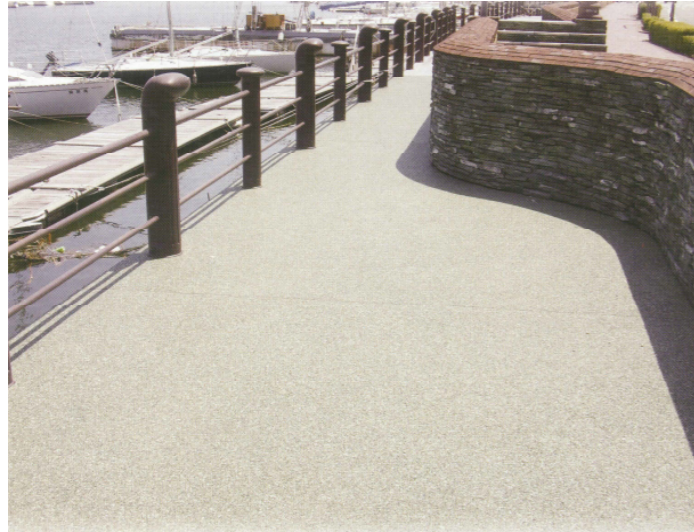
（ファイバーレジン舗装の施工事例）
