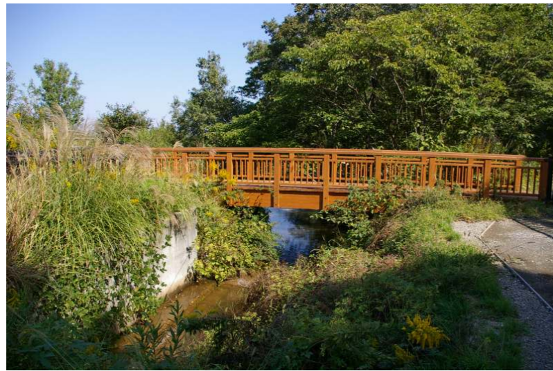
(谷口池西側の既設人道橋)
