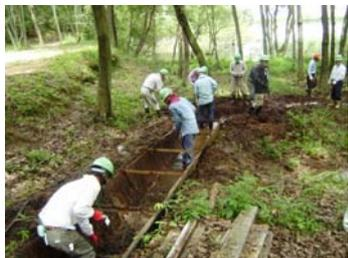
水の広場コルゲート管土砂撤去作業
