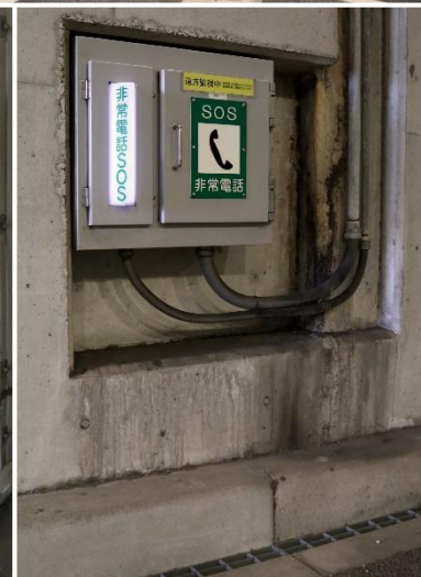
コンクリートの継ぎ目部分には漏水対策。
