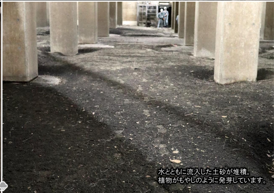
令和3年度までに、満水を5回経験しています。 満水時の水位の痕跡が柱に残っています。
