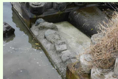
下流端に石を配置しコンクリートで固定
