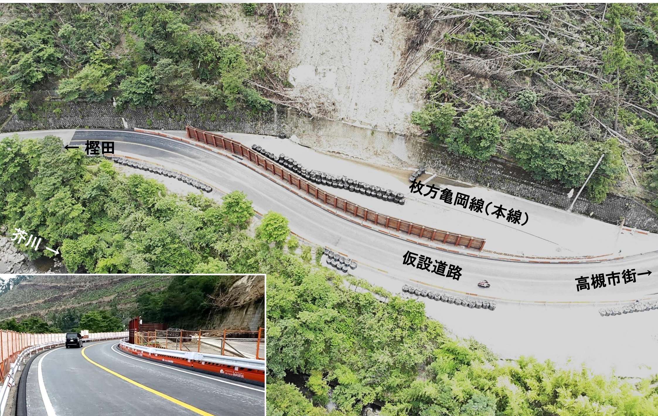
仮設道路を2車線対面通行で利用開始。法面の本復旧までは仮設防護壁(L型ガード)で保護。
