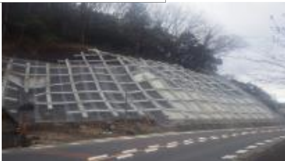
道路のり面对策
