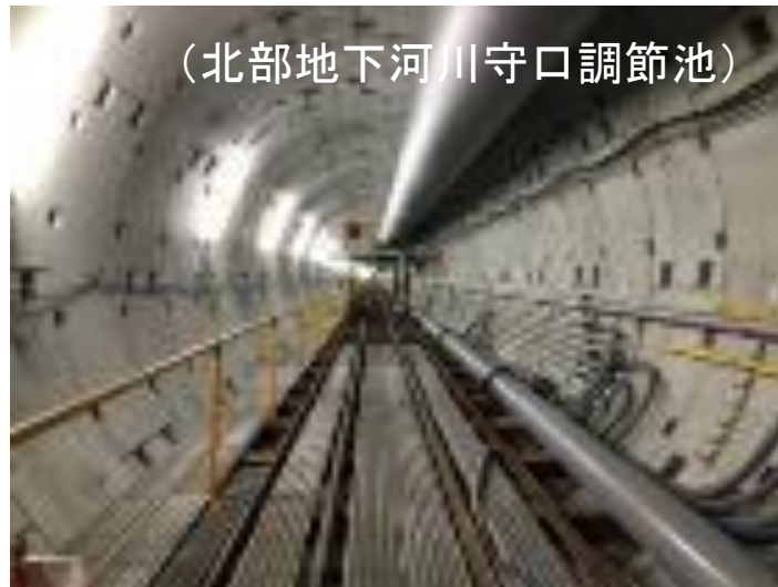
地下河川・流域調節池整備
