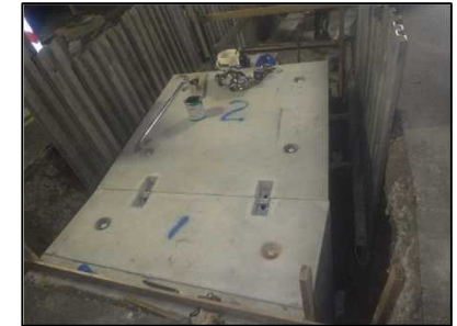
令和7年度施工写真
