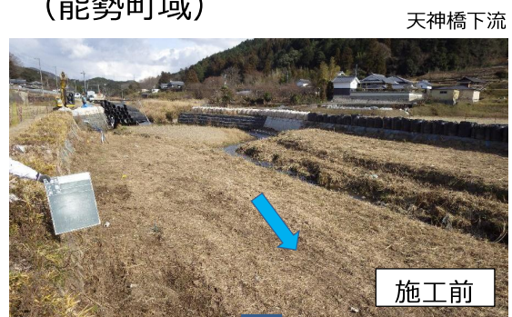
田尻川改修 （能勢町域）
