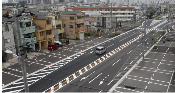
写真②(供用済み区間 遠景)
