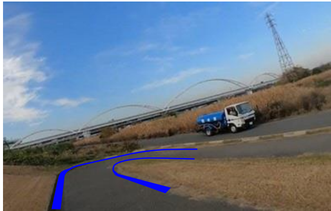
堤防天端から高水敷に移動するスロープ
