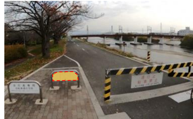
河川管理用車両が通行する河川管理用通路
