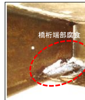
橋桁の腐食
